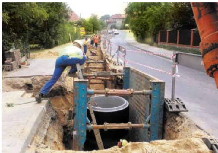
Prace przy realizacji I etapu „Gospodarka ściekowa na terenie Zielonej Góry”. Etap II zatwierdzony do dofinansowania z Programu Operacyjnego Infrastruktura i Środowisko
