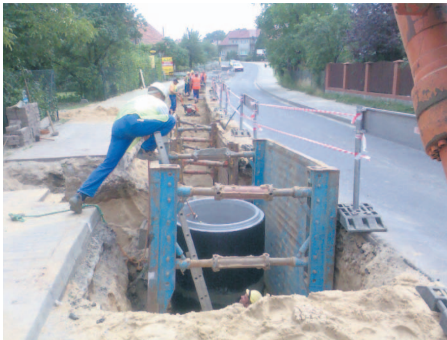
„Gospodarka ściekowa na terenie Zielonej Góry- Etap II” prace przy realizacji projektu zatwierzonego do dofinansowania z Programu Operacyjnego Infrastruktura i Środowisko
